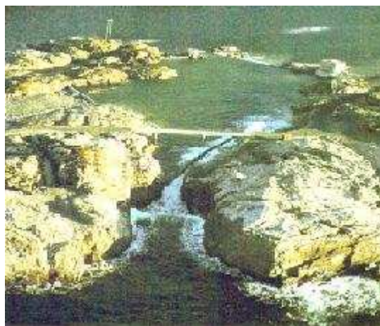
Figura 4.5. Dispositivo Tapchan instalado en las costas noruegas en la década de los 80. Fue destruido por una tormenta.
