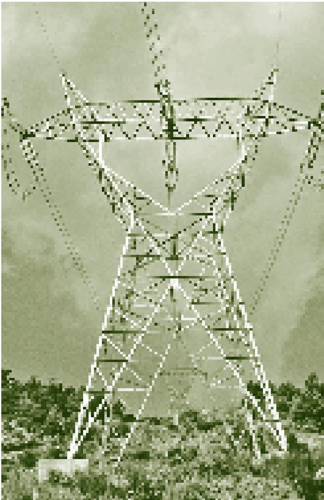
como el denominado efecto corona que tiene como consecuencia la emisión de ruido, interferencias de radiofrecuencia, generación de ozono troposférico y efecto atractor de aerosoles contaminantes.
