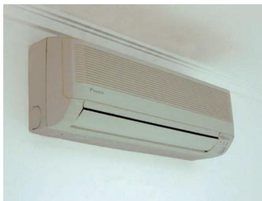
Figura 8. Unidad interior de aire acondicionado
