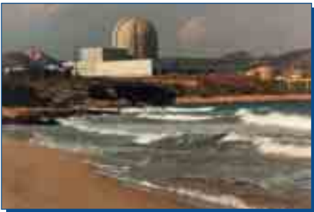
Central nuclear de Vandellós.
