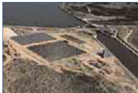
Instalación piloto de una central fotovoltaica. Toledo PV.
