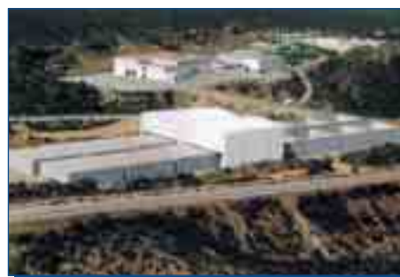
Central de almacenamiento de residuos radiactivos de baja y media actividad de El Cabril (Córdoba).
