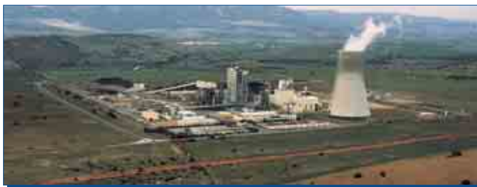
Central térmica de ELCOGAS de gasificación de carbón con ciclo combinado (Puertollano).
