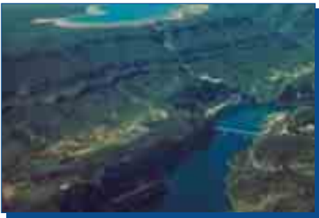
Aprovechamiento de Cortes-La Muela. Depósito superior de bombeo y embalse inferior.
