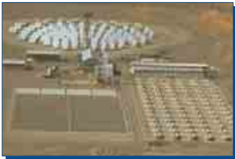
Plataforma solar de Almería.
