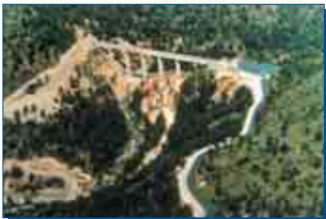
El aprovechamiento de los recursos hidráulicos conlleva la realización de otras infraestructuras en su entorno.
