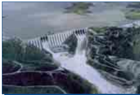
Central de acumulación con regulación hiperanual.
