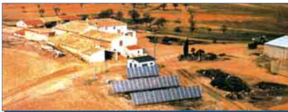
Instalación fotovoltaica rural experimental (Caravaca-Murcia).
