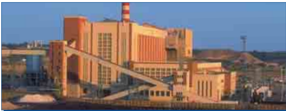
Planta de demostración de lecho fluido a presión de Escatrón (Teruel).
