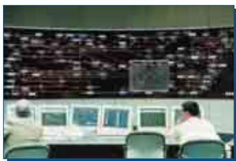
Centro de control del Operador del Sistema para la gestión del transporte eléctrico.
