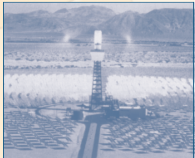
Solar Two tower SEG, 50 MW, sur de Barstow, CA
