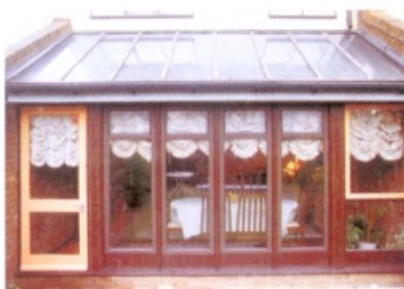
Figura 22 Sistema de captación sustituyendo a la cubierta de la vivienda
