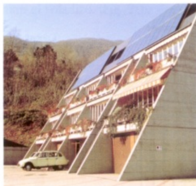
Figura 24 Captadores incorporados a fachada
