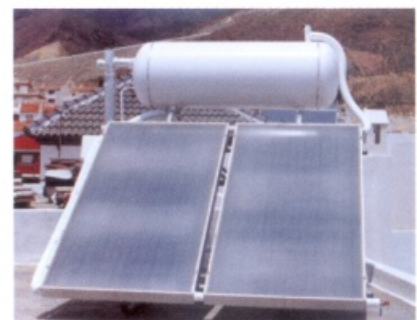
Figura 17 Equipo solar doméstico en azotea
