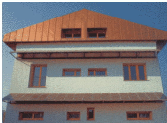
Módulos fotovoltaicos como toldos/parasoles
