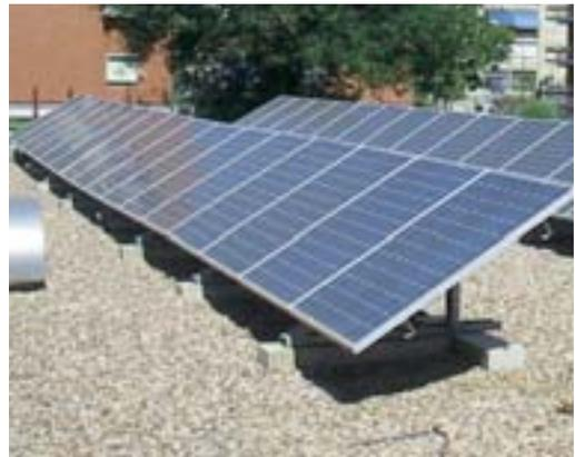
El generador fotovoltaico es el elemento encargado de transformar la radiación solar en energía eléctrica. Esta electricidad se produce en corriente continua, y sus características dependen de la intensidad energética de la radiación solar y de la temperatura ambiente.
