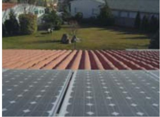
Se trata de una instalación de 2.050 Wp, cuya producción anual ronda los 2.530 kWh, con lo que se logra evitar la emisión a la atmósfera de 2.024 kg de CO<sub>2</sub> al año. Además, la instalación tiene un claro carácter demostrativo, dado que se ha instalado un panel informativo en el que se pueden visualizar los datos de producción de energía y de ahorro de emisiones de CO<sub>2</sub>.
