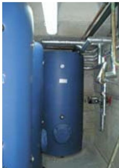
El sistema de acumulación está formado por uno o más depósitos de agua caliente. La dimensión de los depósitos de almacenamiento deberá ser proporcional al consumo estimado y debe cubrir la demanda de agua caliente de uno o dos días.
