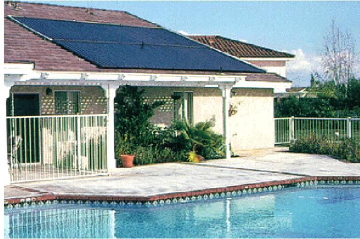
Figura E.14: Colectores Solares de Plástico para Climatización de Piscinas Descubiertas.
