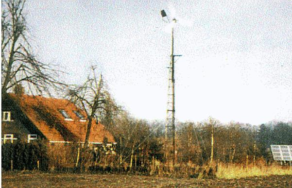
**Ejemplo 1:** Sistema consistente en una combinación entre turbina LMW 1000, con paneles solares de 456 Wp y un grupo generador de 2 kVA.
