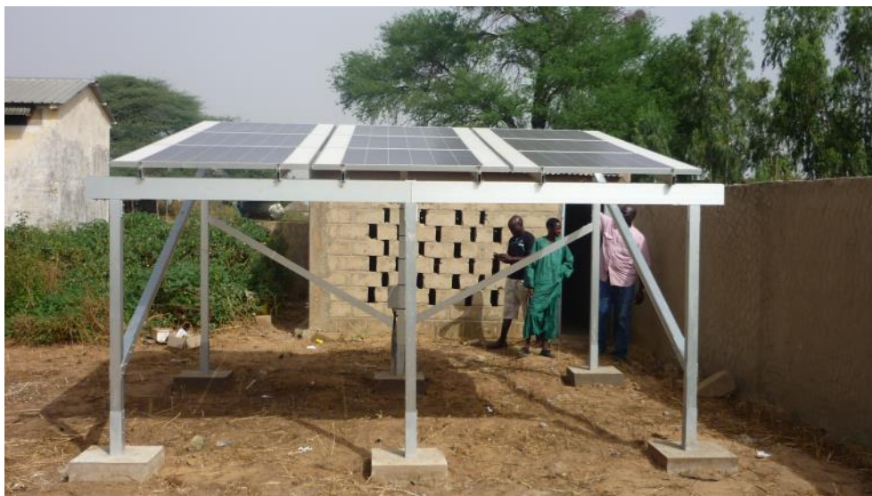
Instalación fotovoltaica de 1,15 kW en la aldea de Fordou (Ranerou) al noroeste de Senegal (ITER/ASER/AIET/Cabildo de Tenerife)
