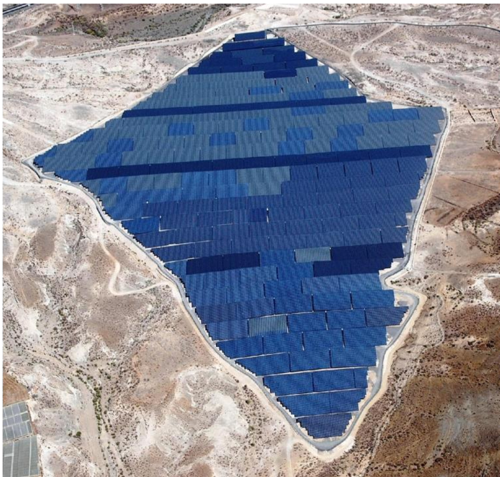
Plataforma fotovoltaica de 20 MW SOLTEN I y II en el sur de Tenerife
