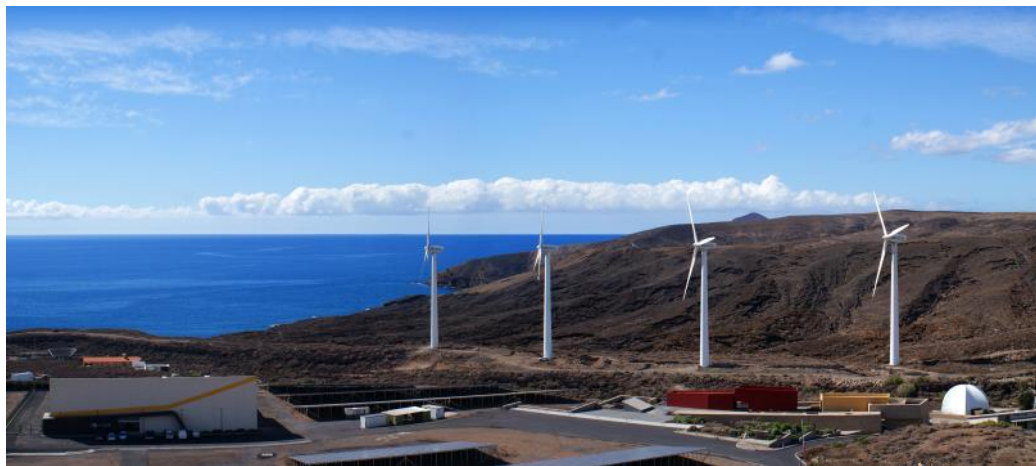
Instalaciones de Energías Renovables en el ITER. Tenerife (España)
