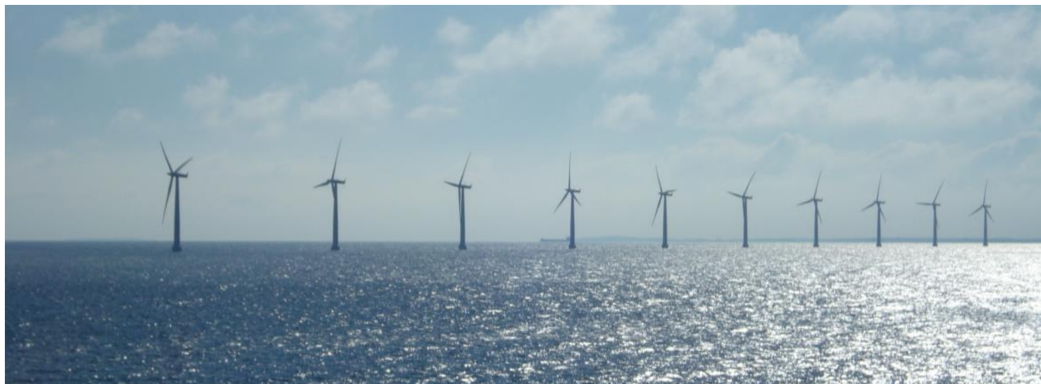
Parque Eólico Offshore 23 MW en Samsø (Dinamarca)
