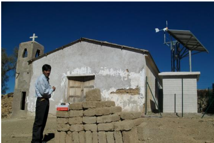
Sistema Mixto Solar-Eólico. Comunidad Rural Bolivia. Programa EURO-SOLAR
