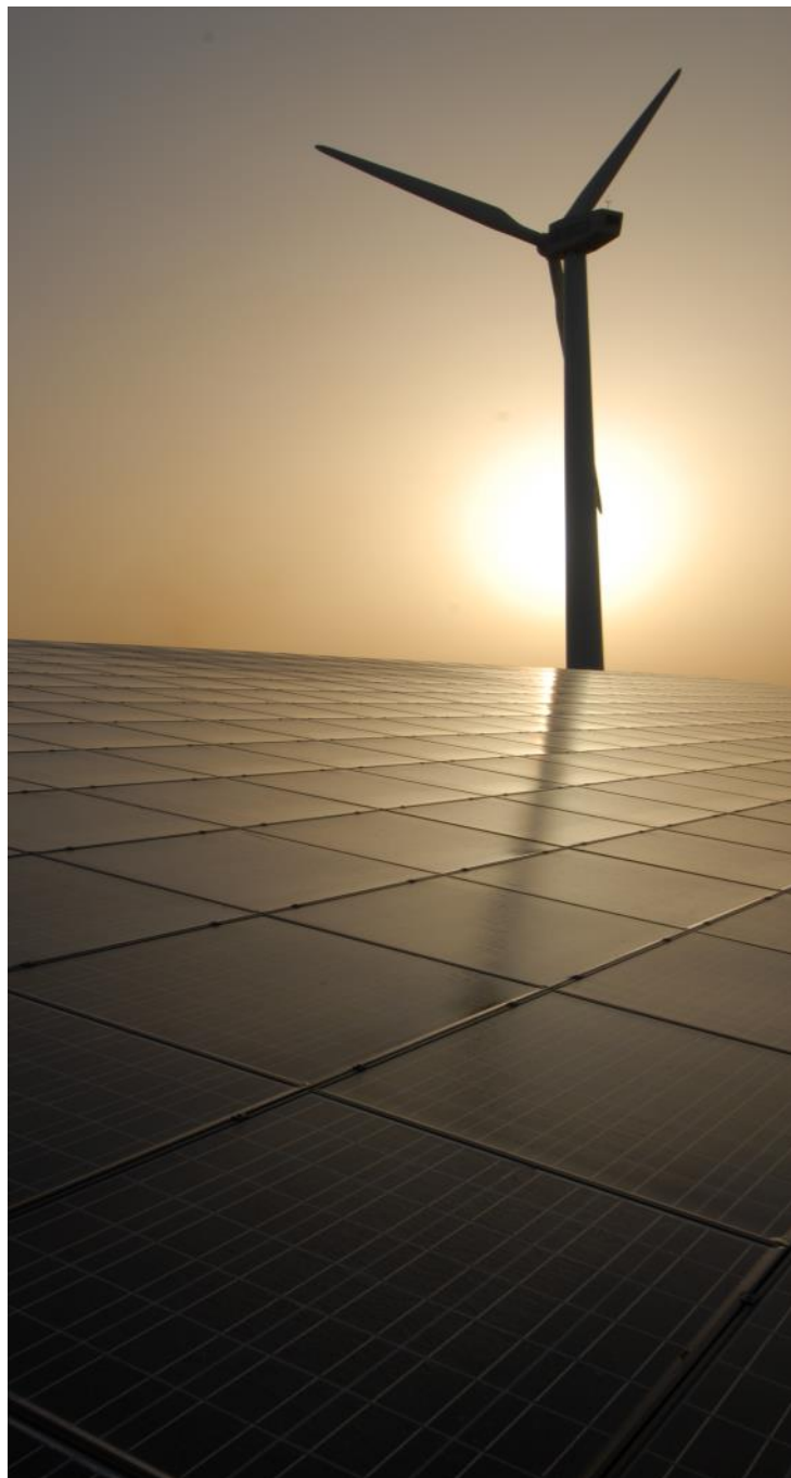
Detalle de Aerogenerador junto a planta fotovoltaica
