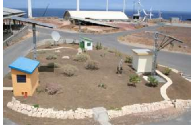
Prototipos Programa Euro-Solar instalados en el ITER (Tenerife)
