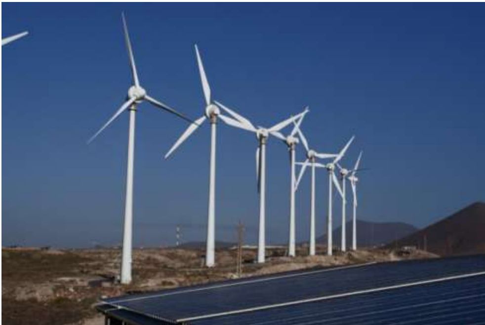
Parque Eólico en el Instituto Tecnológico y de Energías Renovables de Tenerife.
