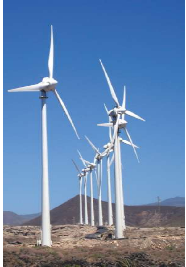
Parque Eólico en el Instituto Tecnológico y de Energías Renovables de Tenerife.
