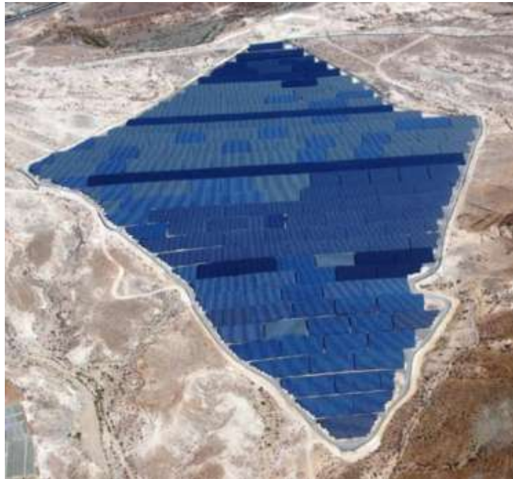
Planta FV conectada a red SOLTEN I (13 MW).
