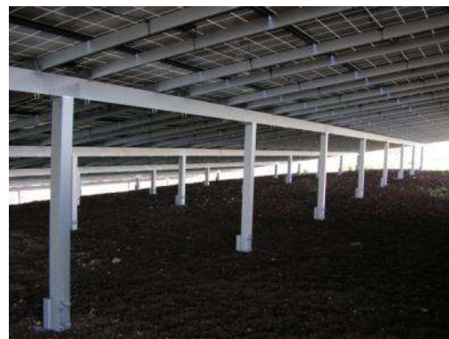
Ilustración 11. Vista de la estructura
