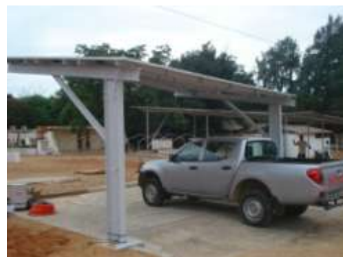
Ilustración 5. Vista de la estructura / pérgola
