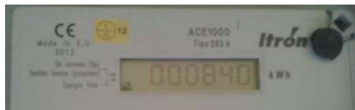
Ilustración 11. Contador de conexión a red (28/06/2013)
