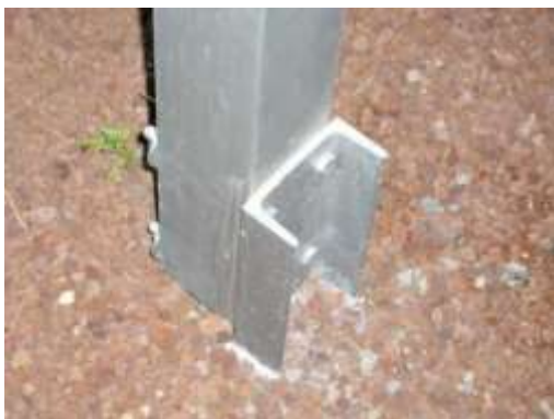
Ilustración 10. Vista de un pilar
