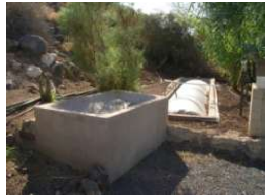
Ilustración 21. Vista del Biodigestor
