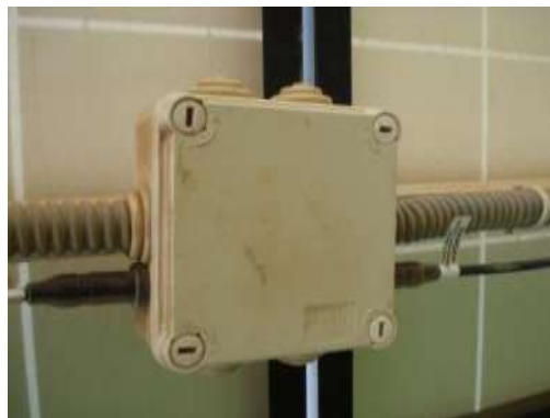
Ilustración 9. Caja conexión serie – paralelo
