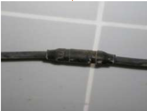
Ilustración 5. Terminales conectados de paneles FV
