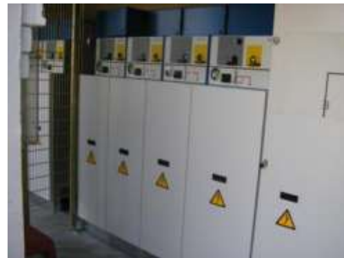
Ilustración 16. Aparata de MT - ITER
