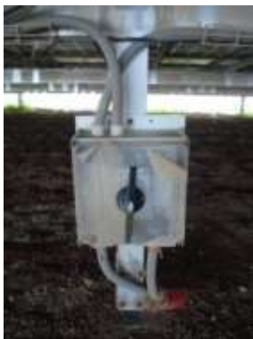
Ilustración 9. Seccionador de CC
