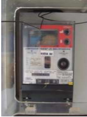
Ilustración 18. Equipo de medida en BT
