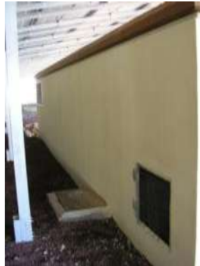
Ilustración 256. Sistema de ventilación
