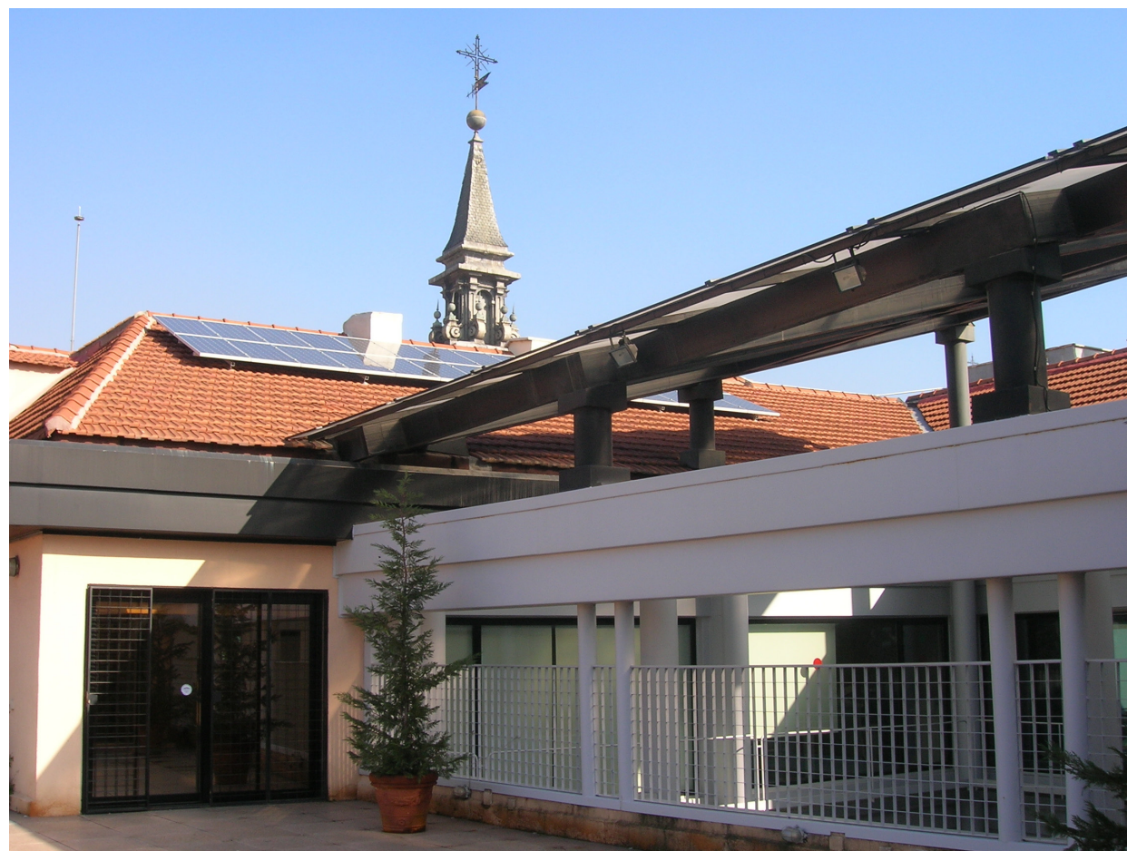
INSTALACIÓN FOTOVOLTAICA SUPERPUESTA (3 kWp) Sede IDAE (Madrid)
