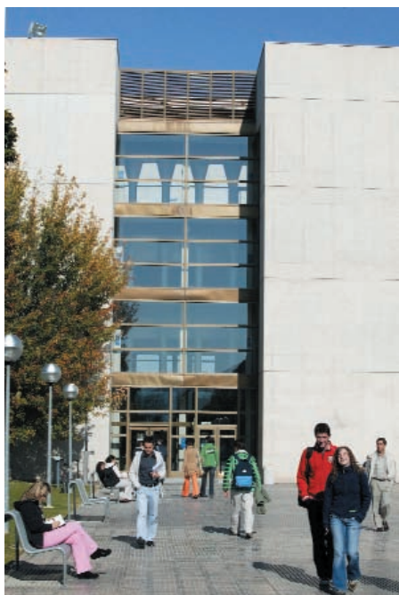
En el año 2006, la Universidad Pública de Navarra firmó un convenio con el CRANA para la realización de un Plan Energético en el edificio del Aulario. Foto UPNA.
