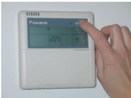
Termostato regulador de temperatura de calefacción.
