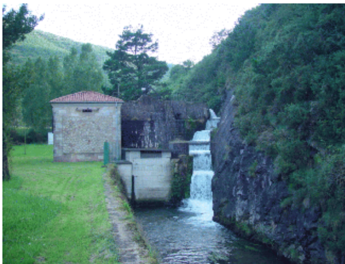
Figura 8.14: Central hidroeléctrica de santa Lucía (río Saja)
