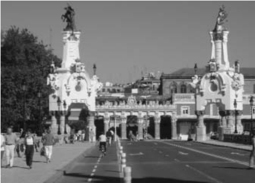
Puente de María Cristina, con la estación de RENFE al fondo. Los cuatro puentes centrales de San Sebastián disponen de carril-bici.
