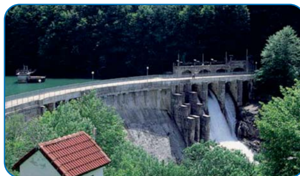
Figura 9: Presa de Irabia (Navarra)
