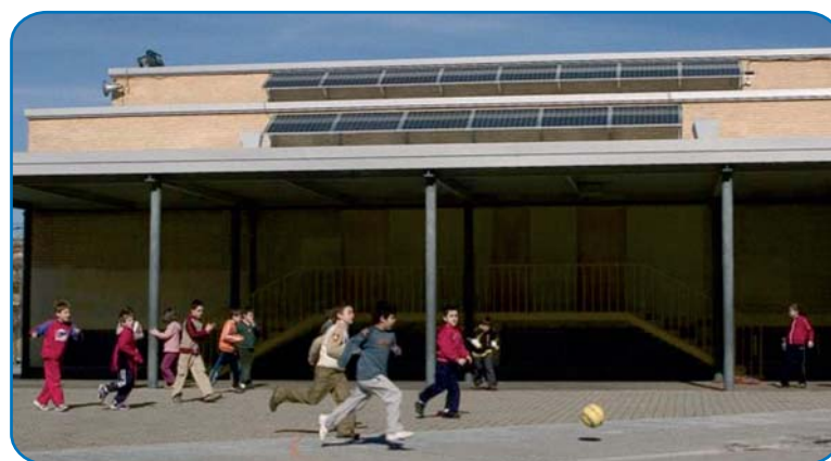
Figura 8: Instalación solar de la Ikastola Hegolade perteneciente a la “Red de Colegios Fotovoltaicos”. (Fuente: Agencia Energética del Ayuntamiento de Pamplona)
